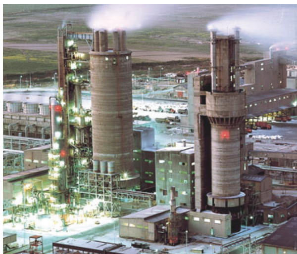
Сл. 13. Комбинирана постројка за производство на амонијак и уреа
