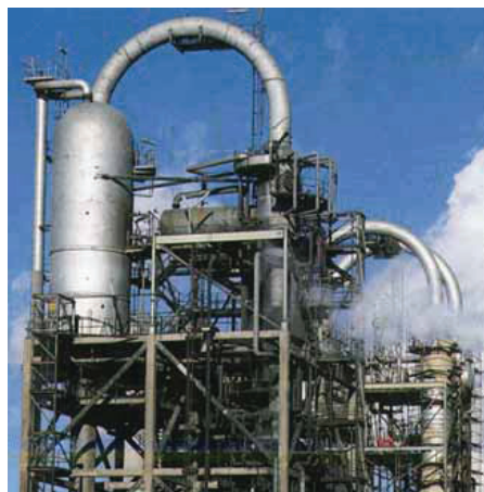
Сл. 14. а) Реактор со циркулирачки флуидизиран слој (Straight-Through Transport Reactor)
